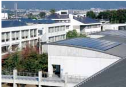
校舎屋上に設置したソーラーパネル
