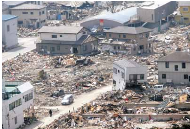
2011年3月11日、三陸沖を震源とするマグニチュード9.0の大地震は、2万人近くの尊い命を奪い去った。写真は、東日本大震災からおよそ1カ月後の石巻市大街道南地区。
