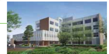
8号館(建設中) 教育学部(設置認可申請中)の専用校舎で、多目的室、アクティブラーニングスペースを備えた講義棟と、体育館、部室棟を整備します。
