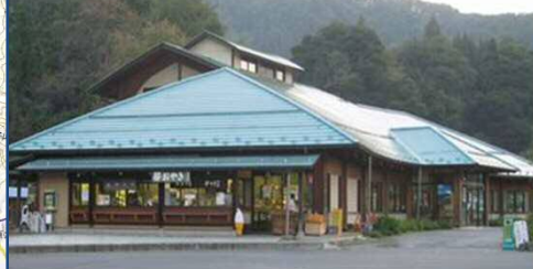
【道の駅中条 全景】
